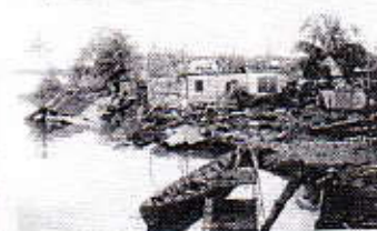
▲受到水災毀壞的木屋。
